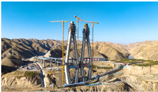
▲建设中的桑园子黄河大桥
