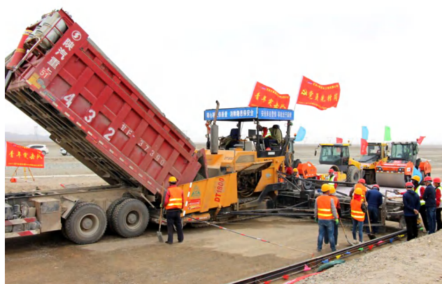
▲甘肃路桥集团万泰公司发挥党员先锋岗和青年突击队的作用,项目建设进展顺利 吴庆 摄
